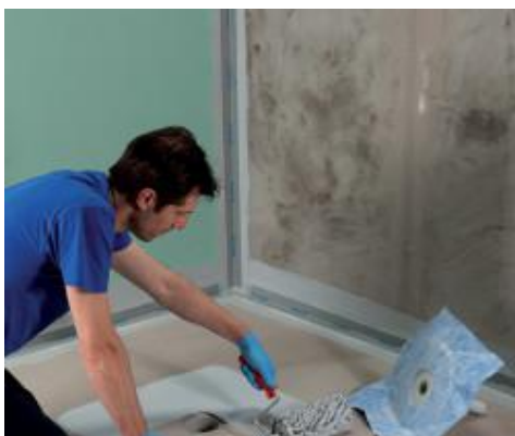
Inštalácia odtokovej vpuste Drain Vertical s použitím Mapegum WPS
