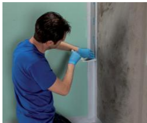
Inštalácia pásky Mapeband PE 120 s použitím Mapegum WPS
